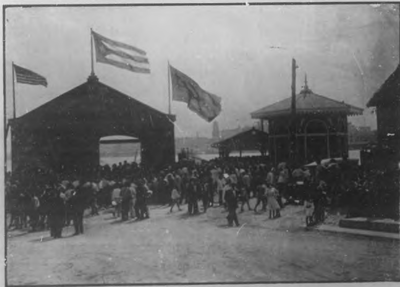
De la Habana á Casa Blanca.—Apendero estación en Casa Blanca.
